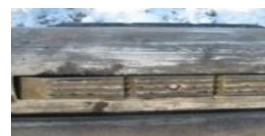
Износ сухарей/плашек противотворотного анкера ШВН
